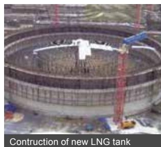
Construction of new LNG tank
